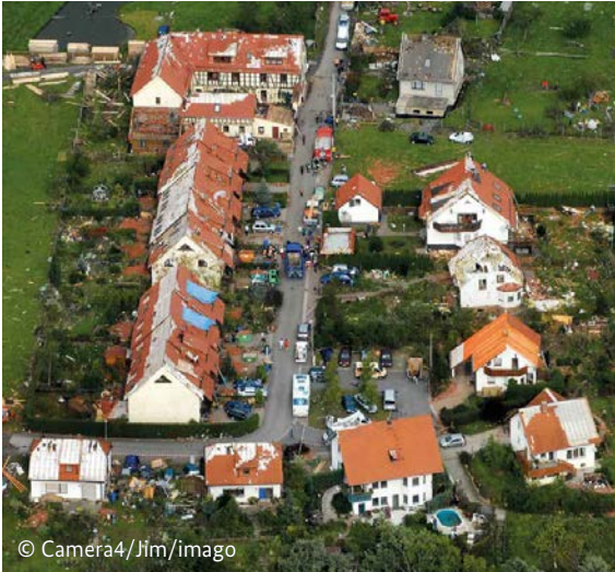
Von einem Tornado zerstörtes Wohngebiet in Quiria, Thüringen, 2006
