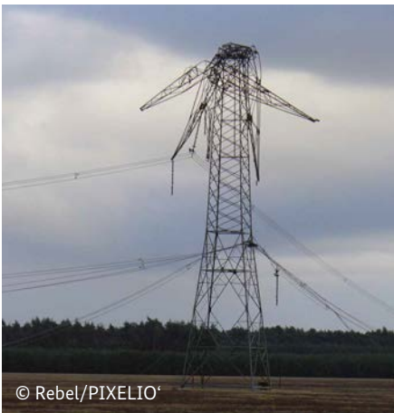
Sturmschaden durch den Orkan Kyrill im Jahr 2007
